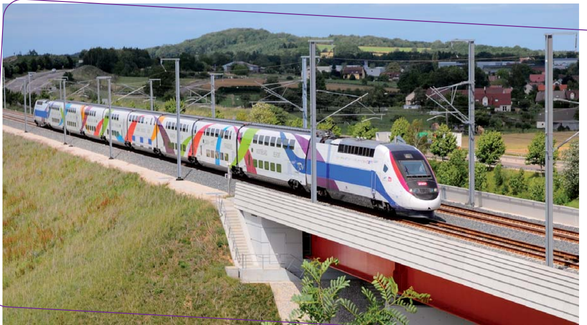
La rame d'essais TGV sur le viaduc de l'Ognon - Voray-sur-l'Ognon (70)
