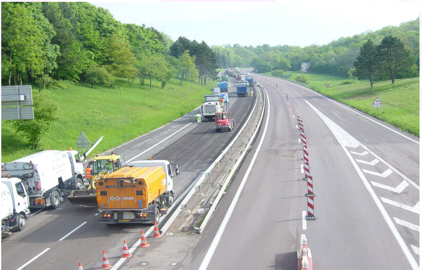
(Modernisation / réfection de la chaussée A38 – Côte d'Or)
